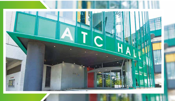
1Fエントランス entrance (1F)
